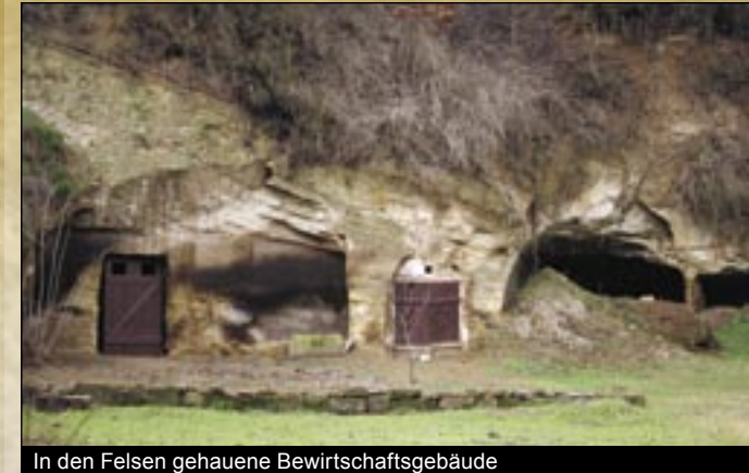
In den Felsen gehauene Bewirtschaftsgebäude
