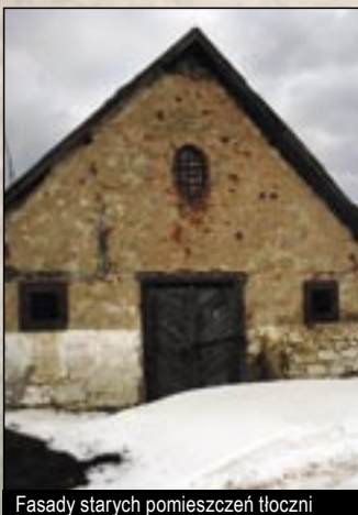
Fasady starych pomieszczeń tłoczni
